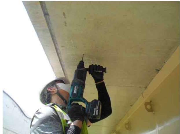
탄산화깊이 측정 현황
